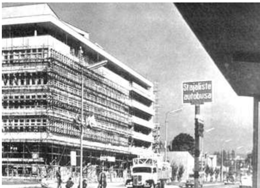
Zgrada DOZ-a Direkcija za NR Hrvatsku, Zagreb, u izgradnji, 1960.-1962. Fotografija preuzeta sa Interneta
