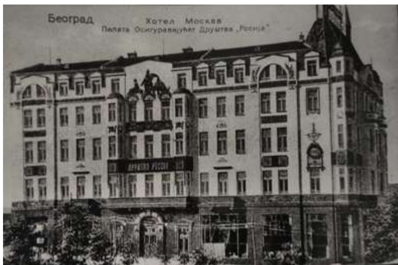
Zgrada osiguravajućeg društva Rosija, Beograd, fotografija razglednice preuzeta sa Interneta
