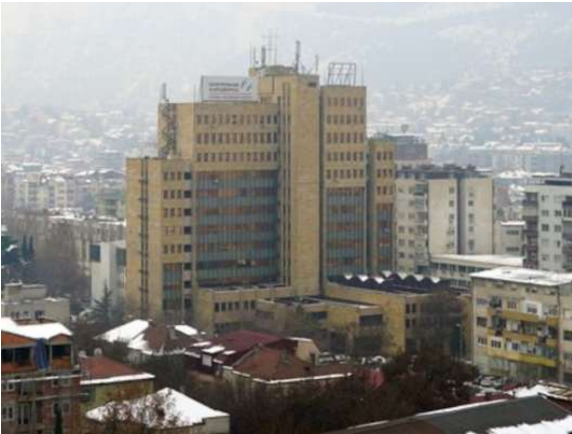
Zgrada nekadašnje ZOIL Makedonija, Skopje, izgrađena 1977., fotografija preuzeta sa Interneta
