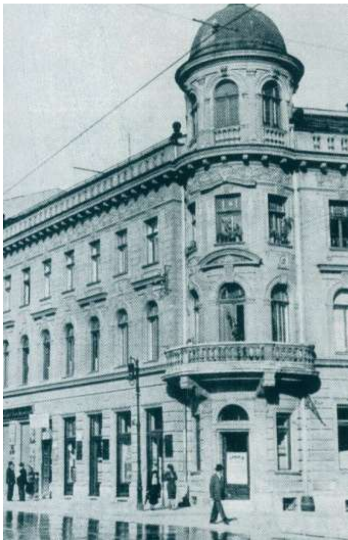
Zgrada sa odjeljenjem društva Srbija u Sarajevu Preuzeto sa Interneta
