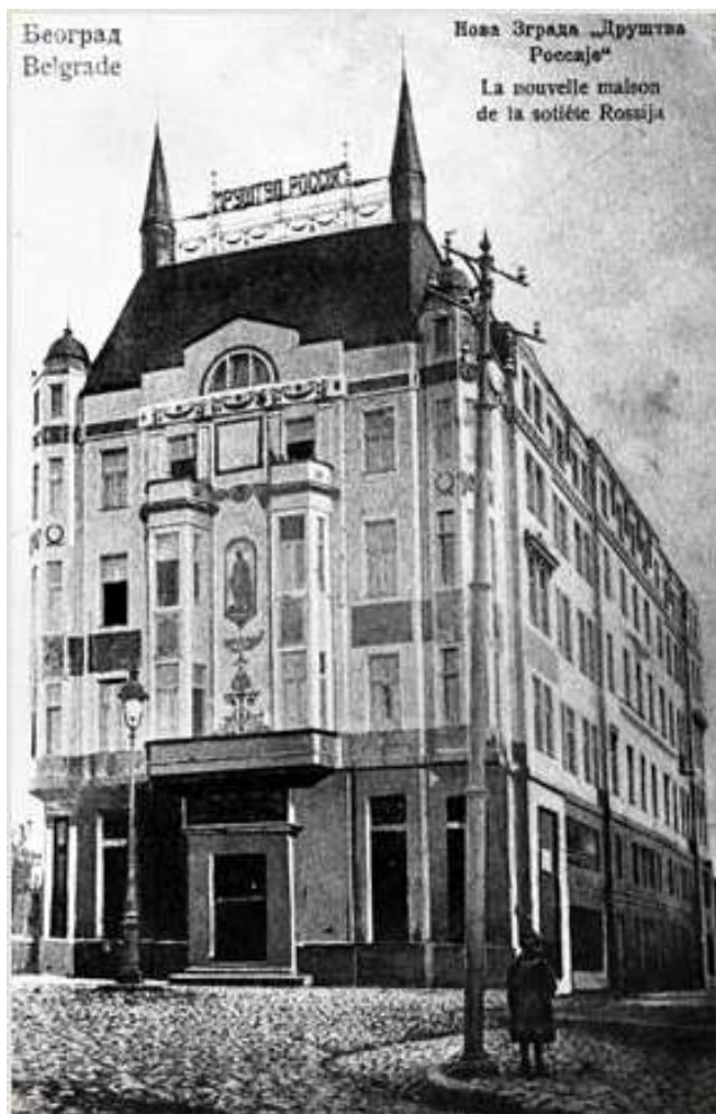
Zgrada osiguravajućeg društva Rosija, Beograd, oko 1910., fotografija razglednice preuzeta sa Interneta
